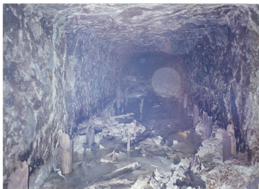
第 2 坑道(泥岩) 破損した坑木が残る
