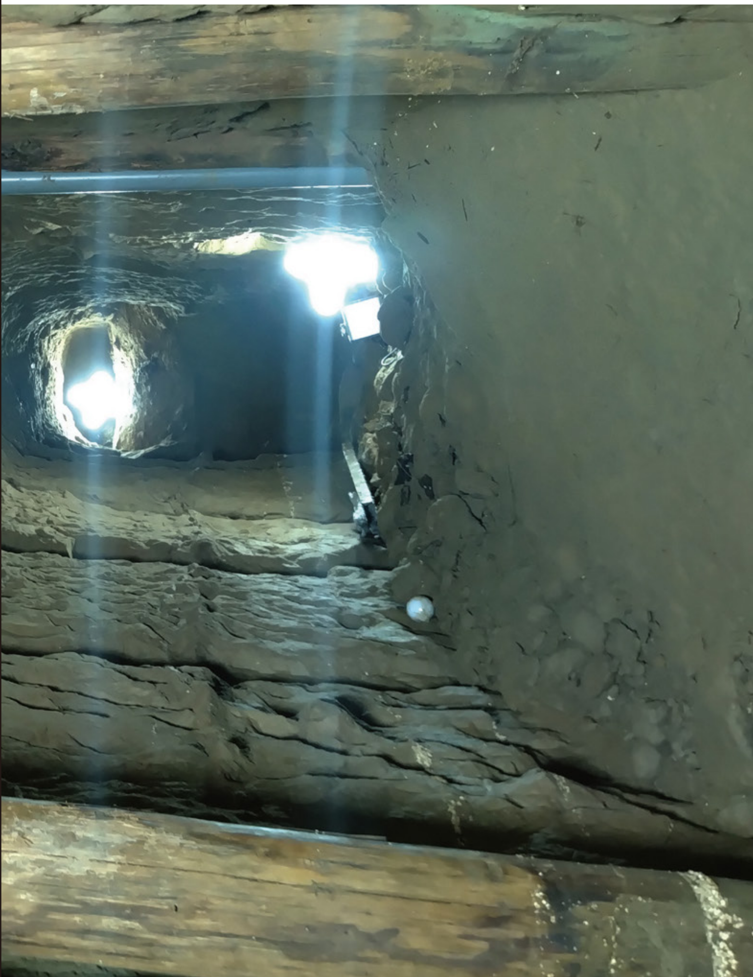
「エンジニアトンネル」[2023年(令和5年)]
