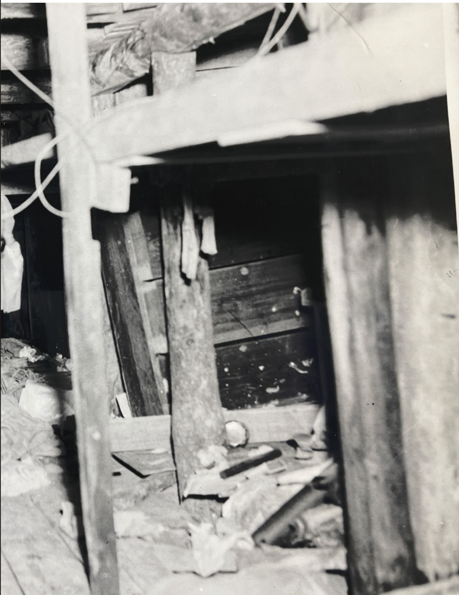
米軍が撮影した第32軍司令部壕の第1坑道中央部分。右側に2段ベッド、左側は通路 出典：米国国立公文書館
