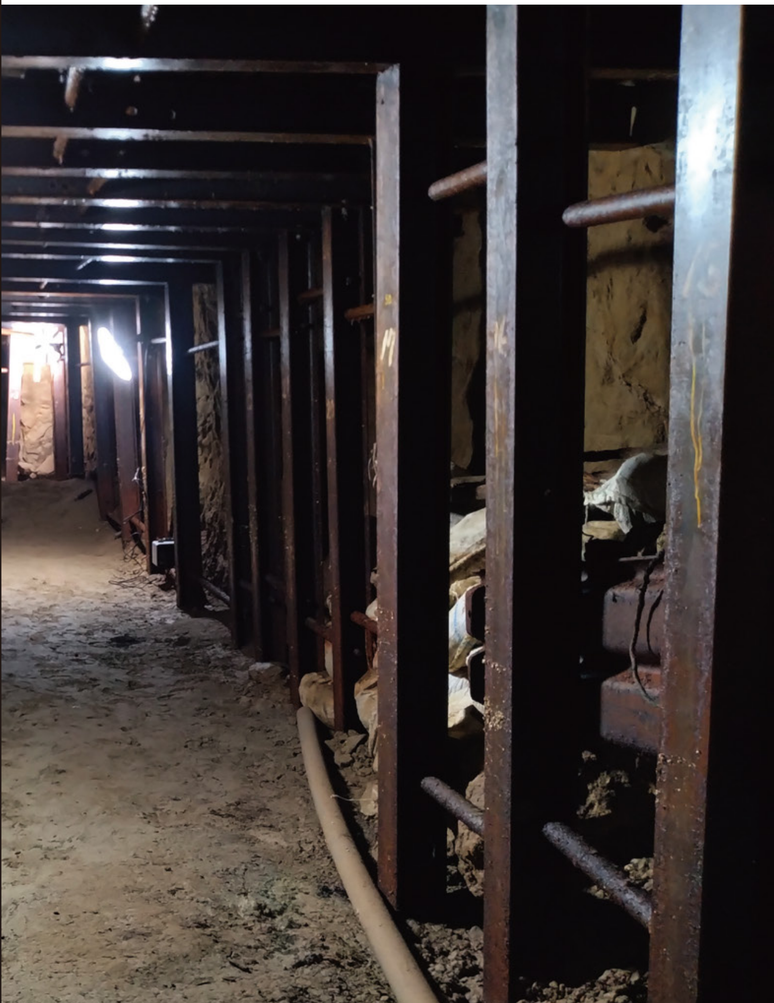
第3坑道内部の様子【2023年(令和5年)】
