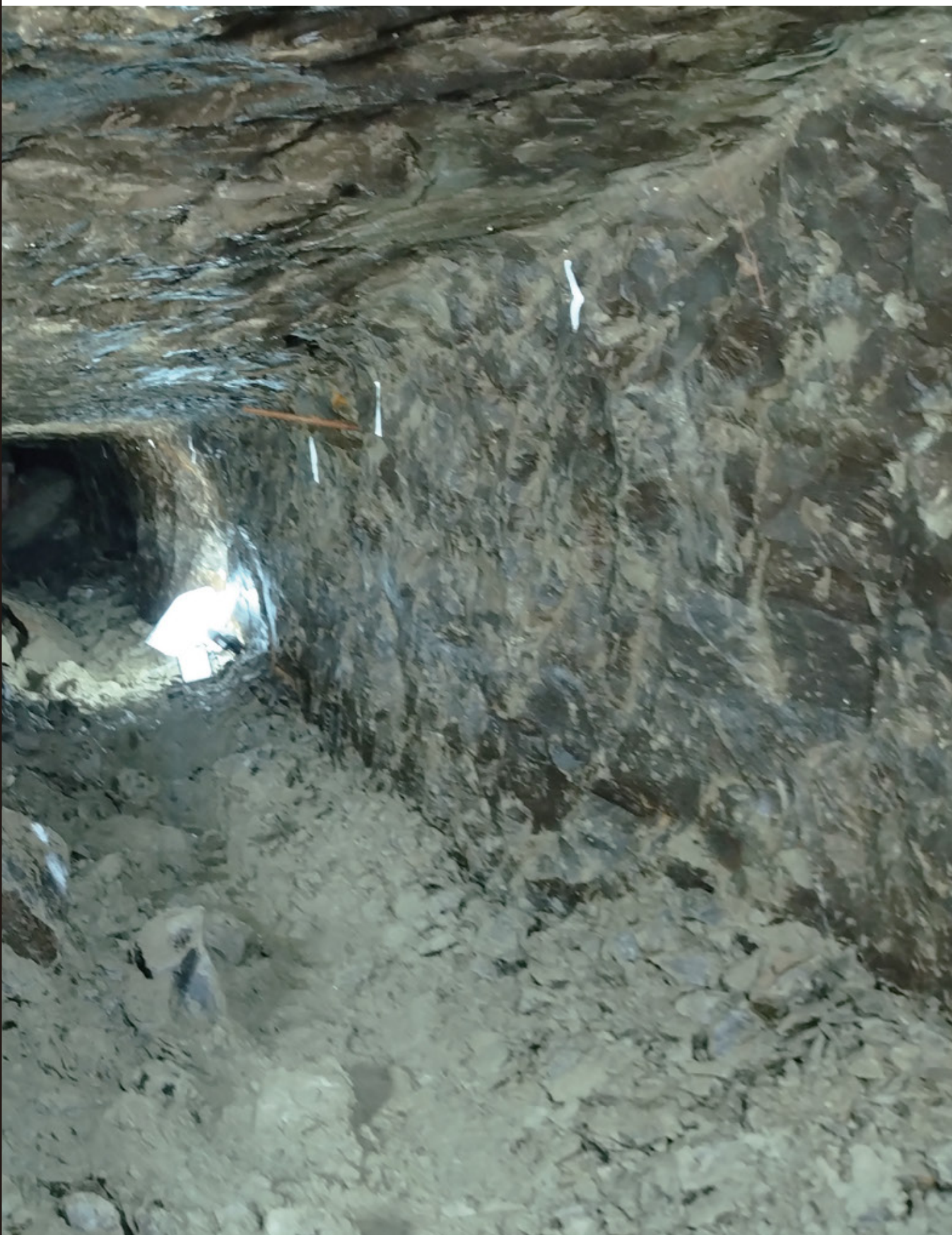
第2坑道内部(無支保工区間)の様子[2023年(令和5年)]
