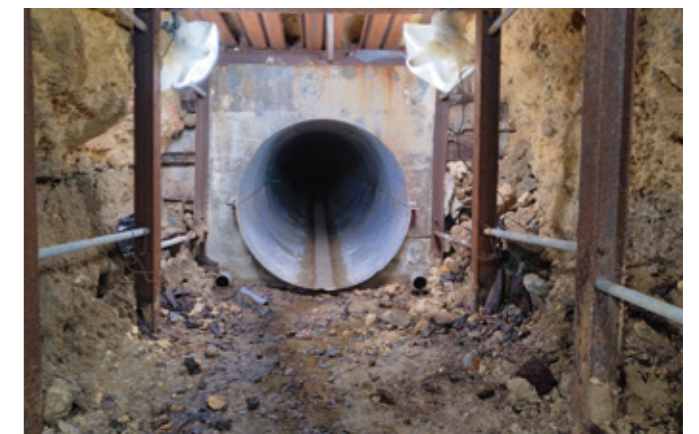
▲第5坑道内部のコルゲート管 [2023年(令和5年)]
