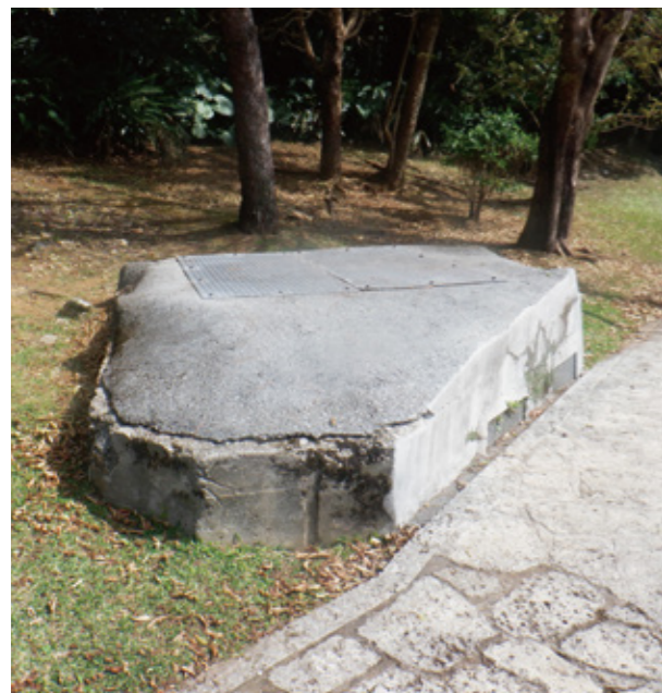
▲通気孔 [2024年(令和6年)12月時点]。 右側部分が切れているのは、道路工事の際に切断されたため。
