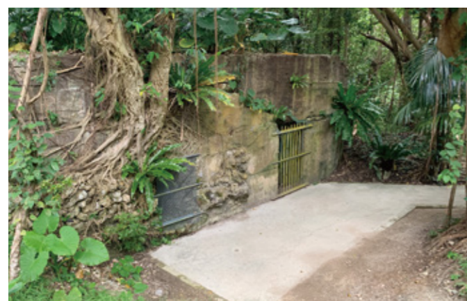
▲掩蔽壕の現在の様子。砲弾の跡にガジュマルが生えている。
