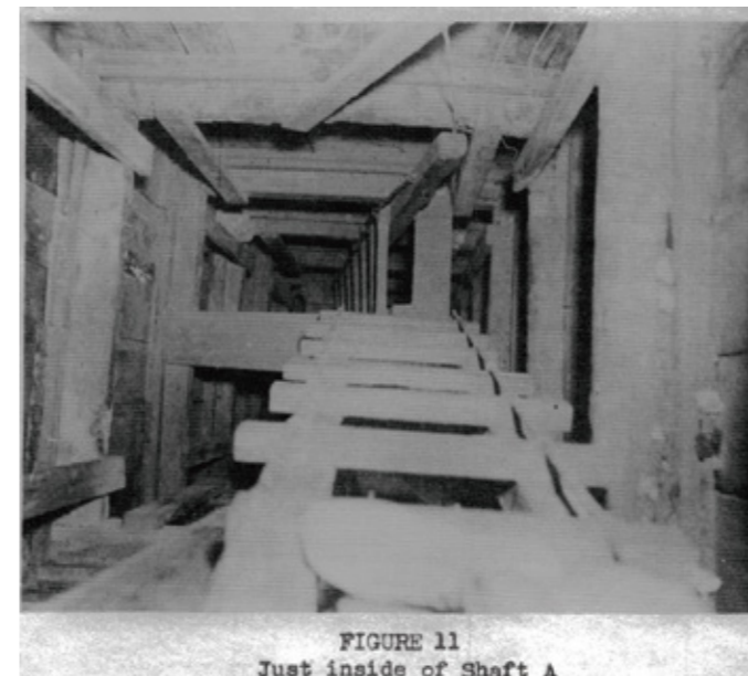
◀立坑Aを上から見た写真 (インテリジェンス・モノグラフより)
