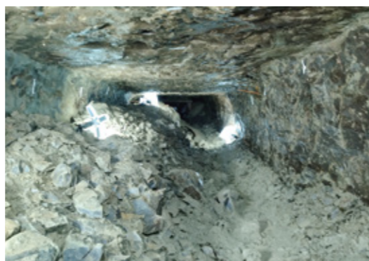
▲第2坑道内部(無支保工区間)の様子[2023年(令和5年)]
