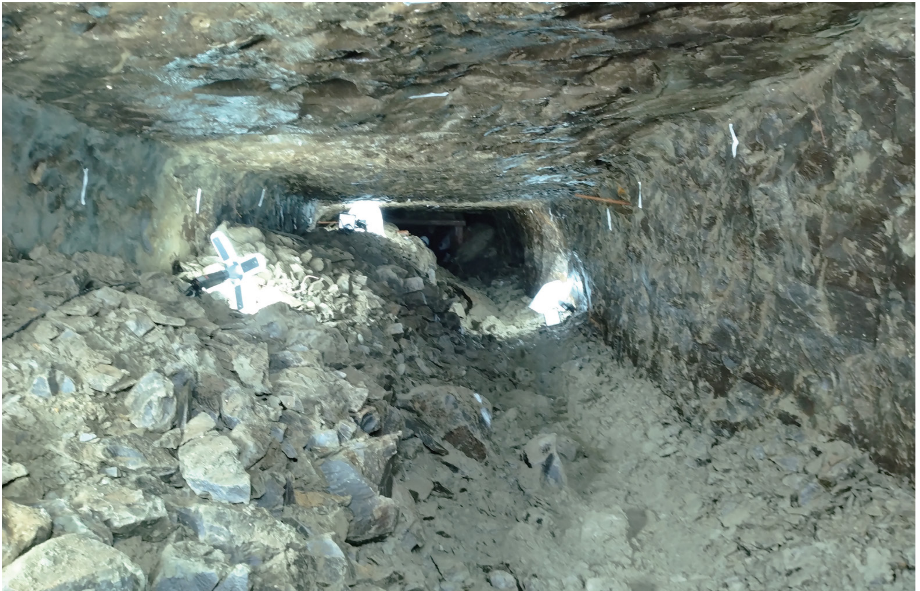
第2坑道内部(無支保工区間)の様子[2023年(令和5年)]
