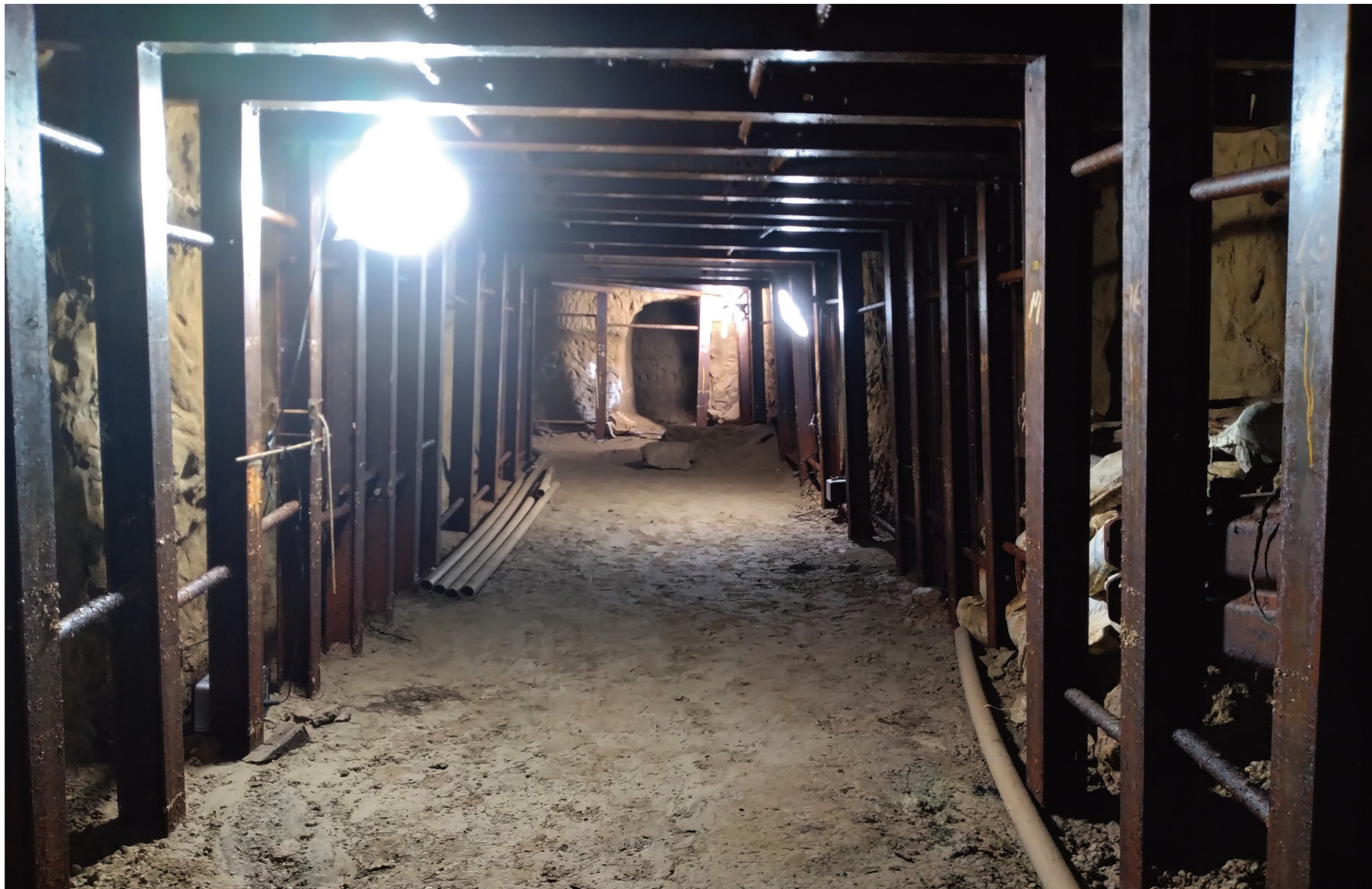
第3坑道内部の様子【2023年(令和5年)】
