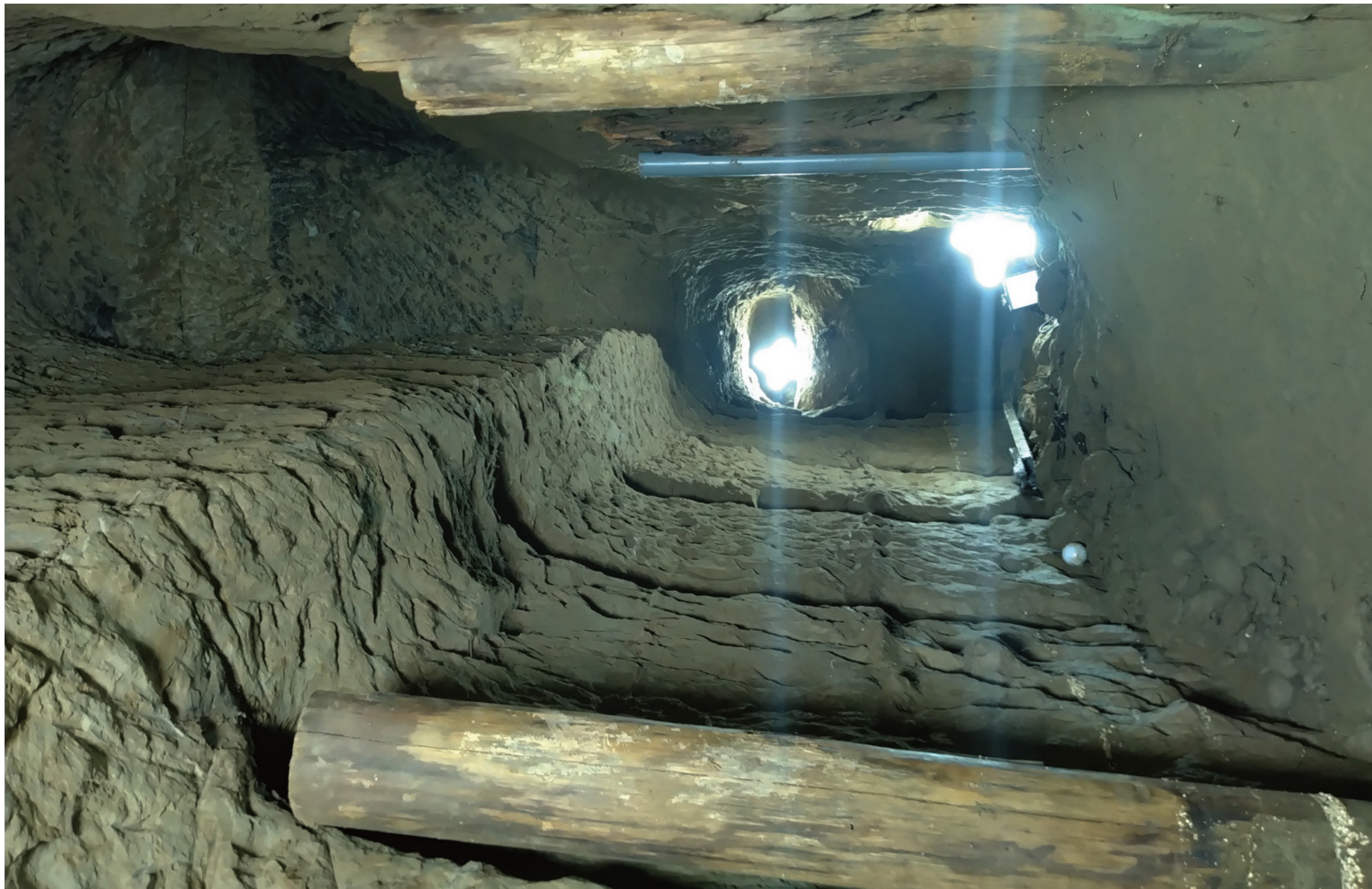
「エンジニアトンネル」[2023年(令和5年)]
